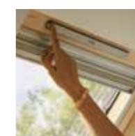
Ugrađena ventilacija omogućuje ulazak svježeg zraka u vašu sobu bez otvaranja prozora (model 1051B).
