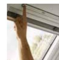
Ugrađena ventilacija omogućuje ulazak svježeg zraka u vašu sobu bez otvaranja prozora (model 0061B).
